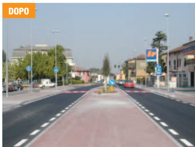
Figura 3 Prima e dopo l'intervento di riqualificazione della SP BS ex SS 11 nel tratto urbano passante per il Comune di Calcinato (BS). Realizzazione della terza corsia centrale promiscua.
