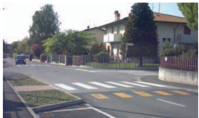
Intersezione realizzata su platea rialzata
