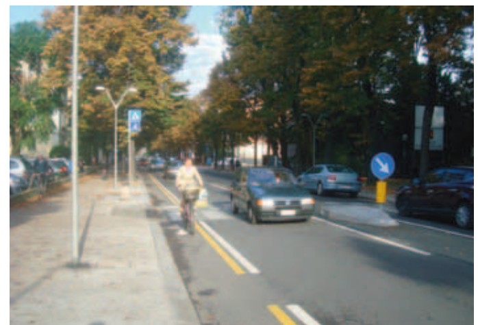
Figura 7 - Corsia ciclabile in carreggiata per il ciclista "lepre" (vuole muoversi velocemente, richiede una protezione minore, usa la bicicletta per andare a lavorare, alla scuola superiore o comunque per muoversi agevolmente all'interno della città e del proprio quartiere) e marciapiede ciclopedonale per il ciclista "tartaruga" (non ha fretta, richiede una protezione maggiore, utilizza la bicicletta per il tempo libero, andare a fare la spesa, andare alla scuola inferiore, muoversi sicuro all'interno del proprio quartiere)
