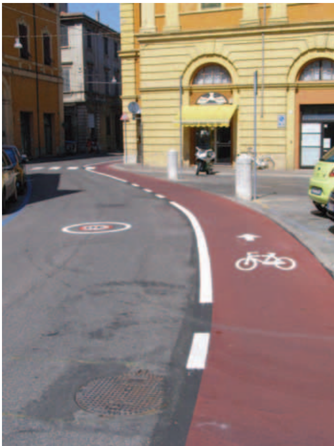
Figura 1. Itinerario ciclabile Corso Garibaldi con restringimento della sede stradale e simboli della moderazione della velocità.
