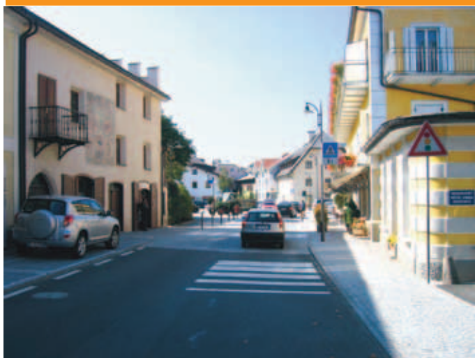
Villabassa (BZ) - Per moderare la velocità di transito lungo la strada di attraversamento che taglia in due il paese e favorire gli spostamenti pedonali è stata realizzata un'estesa piattaforma rialzata in materiale lapideo che richiama il concetto di piazza. Foto: Enrico Chiarini
