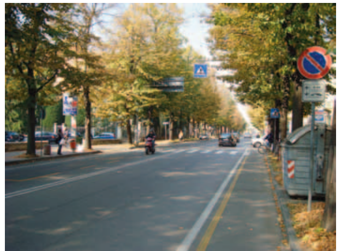
Figura 1 - via Emilia Ospizio prima dell'intervento: l'eccessiva larghezza della carreggiata come causa di velocità eccessive e difficoltà di attraversamento da parte di pedoni e ciclisti (effetto barriera)
