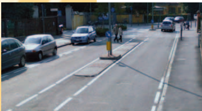
Settimo Milanese (MI), via Libertà. Il parterre centrale presenta le tre tipologie fondamentali sormontabile, semisormontabile ed
