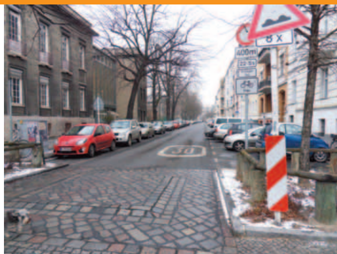
Berlino (D) - Porta di accesso ad una Zona 30, evidenziata dal restringimento della carreggiata e, nel tratto pavimentato in cubetti di pietra, dalla presenza di un cuscinio berlinese. Il restringimento asimmetrico permette di organizzare su un lato parcheggi a pettine, sull'altro parcheggi in linea.
