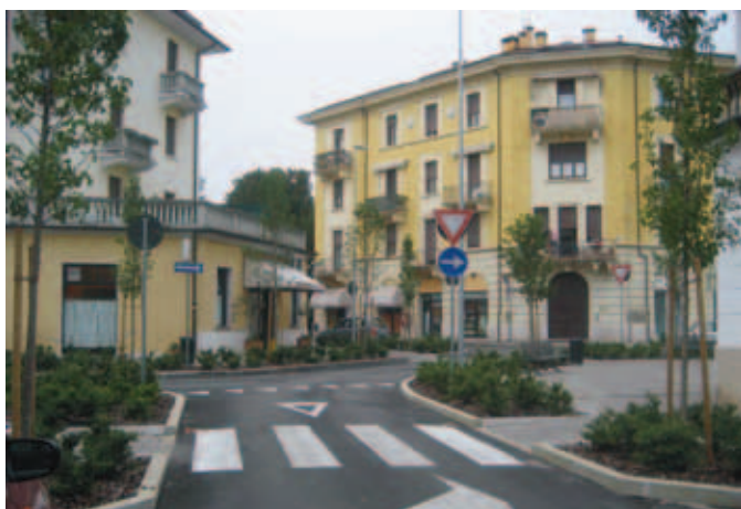
In questo caso, nell'intervento realizzato nel 2012 che reinterpreta la soluzione 1, ha previsto la strada principale con un ampio curvone che mantiene la sezione delle corsie di 4,50 + 4,50 anziché mantenere la tortuosità e una larghezza contenuta in 3,50 + 3,50 con un attraversamento pedonale rallentante centrale.
