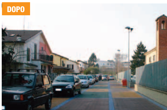
Figura 2 Prima e dopo l'intervento di differenziazione della pavimentazione stradale eseguito all'accesso del complesso scolastico del Villaggio Violino, nel Comune di Brescia
