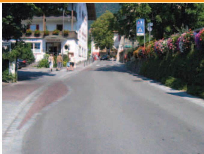
Tirolo (BZ) - Prima di giungere nel cuore del paese, mediante alcuni semplici inserti a raso nella pavimentazione stradale si è creata una strettoia con passaggio obbligato a senso unico alternato, ottenendo una riduzione della velocità dei veicoli. Foto: Enrico Chiarini
