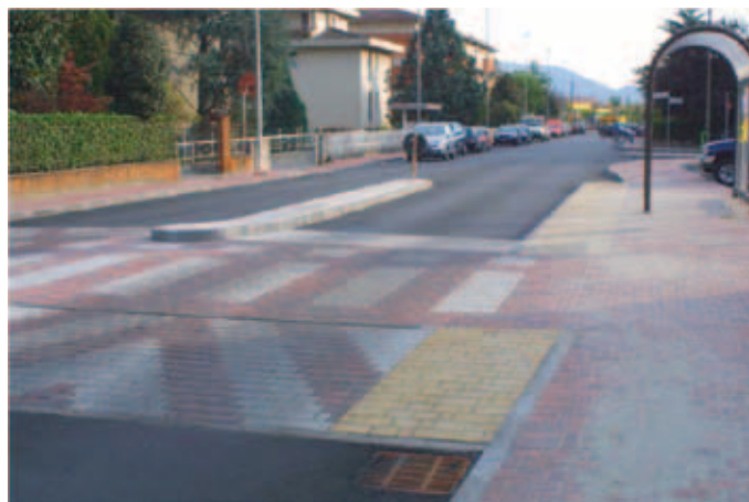
Figura 1 Attraversamento rialzato in corrispondenza della fermata dell'autobus urbano nel Comune di Bovezzo (BS)
