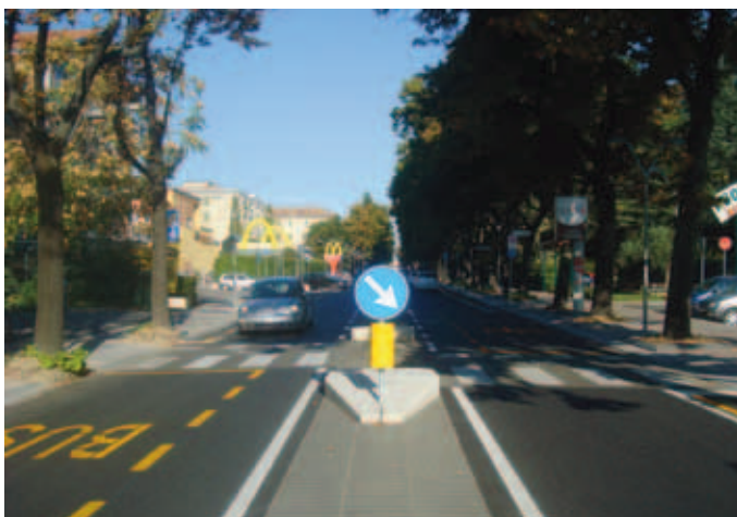
Figura 6 - Fascia centrale polifunzionale trattata con la tecnica dello street print per differenziare le tratte non sormontabili da quelle semi sormontabili o completamente sormontabili
