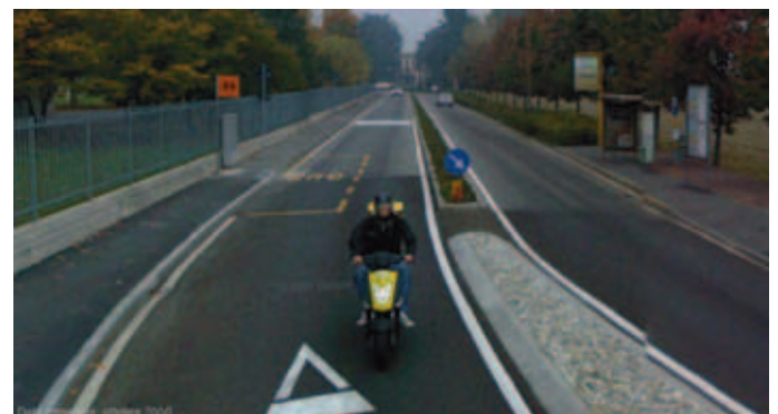
Settimo Milanese, via per Vighignolo. Il parterre centrale di tipo tradizionale realizzato all'inizio degli anni '90 è sì efficace ma presenta un effetto "tunnel" che induce velocità elevate. La ristrettezza della semicarreggiata, non a norma, può invece generare problemi di transito in caso di guasto o incidente.
