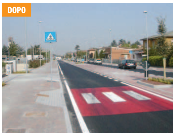
Figura 4 Prima e dopo l'intervento di riqualificazione della SP BS ex SS 11 nel tratto urbano passante per il Comune di Calcinato (BS). Realizzazione della terza corsia centrale promiscua.
