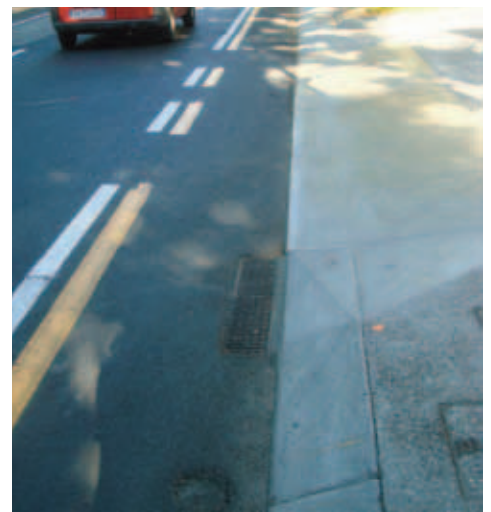
Figura 4 - Le caditoie a griglia ed il cordolo inclinato migliorano la percorribilità della corsia da parte del ciclista
