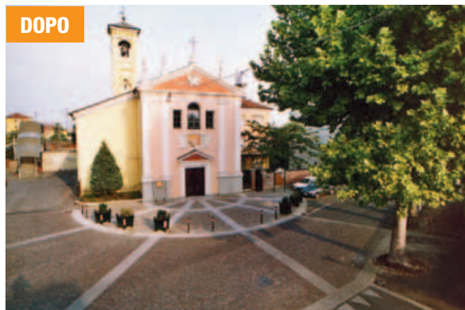
Cosa si può trovare sotto l'asfalto di una strada!
