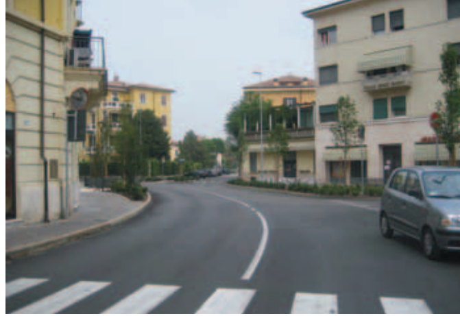
In questo caso, nell'intervento realizzato nel 2012 che reinterpreta la soluzione 1, ha previsto la strada principale con un ampio curvone che mantiene la sezione delle corsie di 4,50 + 4,50 anziché mantenere la tortuosità e una larghezza contenuta in 3,50 + 3,50 con un attraversamento pedonale rallentante centrale.
