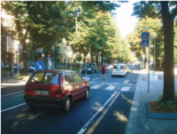
Figura 3 - 'isola salvagente' facilita l'attraversamento della strada da parte di pedoni e ciclisti ed impedisce il sorpasso nei punti più critici
