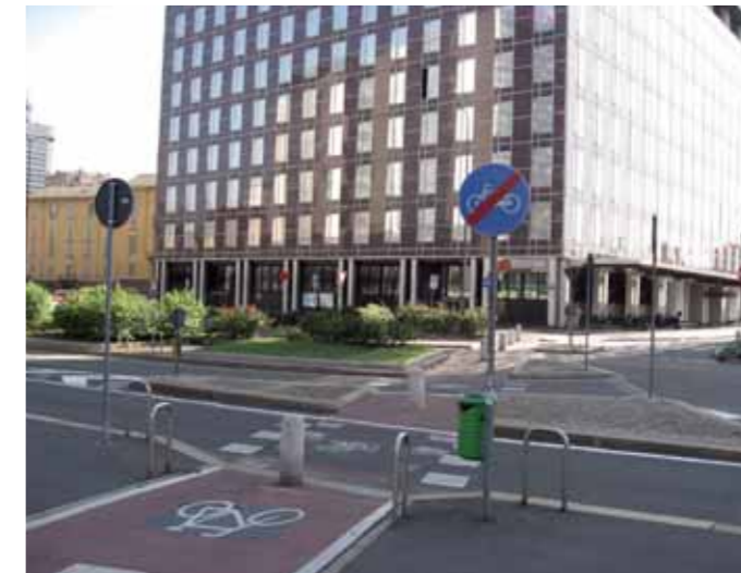
Foto 08 Errata apposizione di segnale di fine pista in corrispondenza di un attraversamento ciclabile (Milano).
