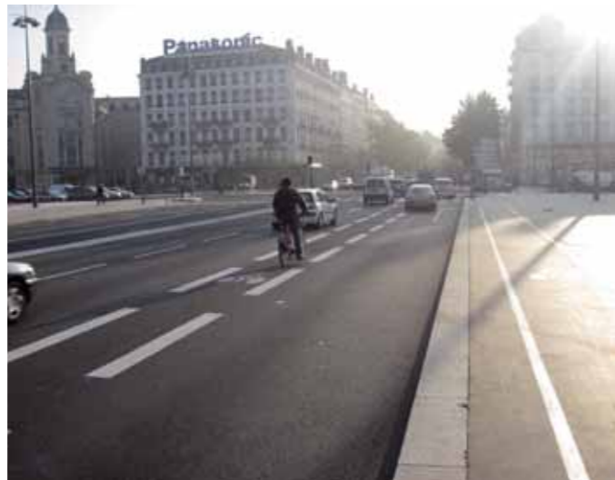
Foto 14 Corsia di attestamento in un'intersezione semaforizzata (Francia).
